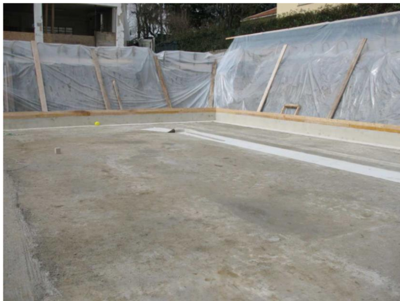
Figura 1: Preparazione del piano di posa
