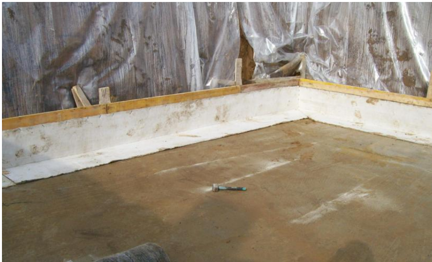
Figura 2: Stesura del Bentotelo sui casseri
