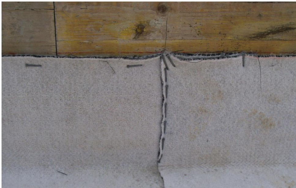
Figura 6: Chiusura delle sovrapposizioni tra i teli.
