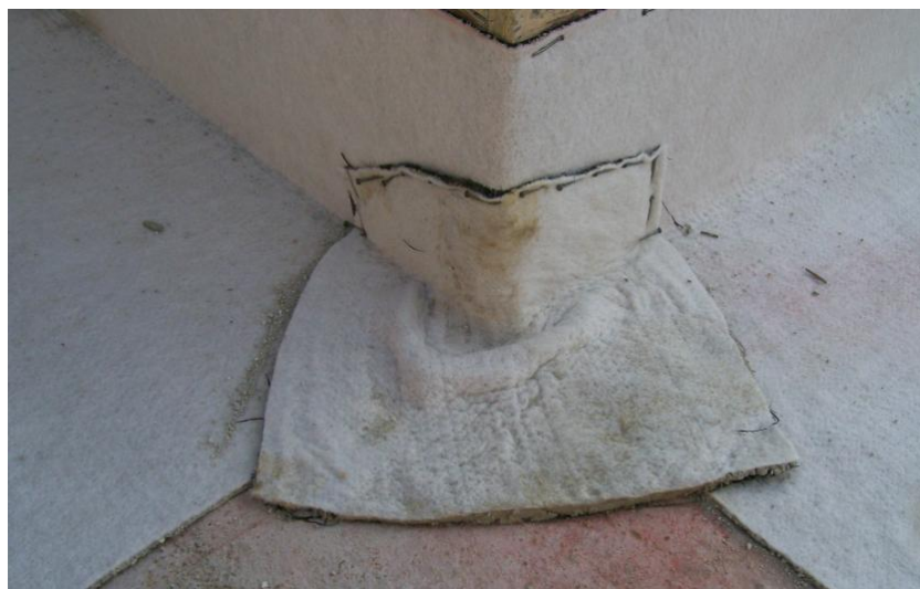
Figura 4: Stesura del Bentotelo su un angolo aperto
