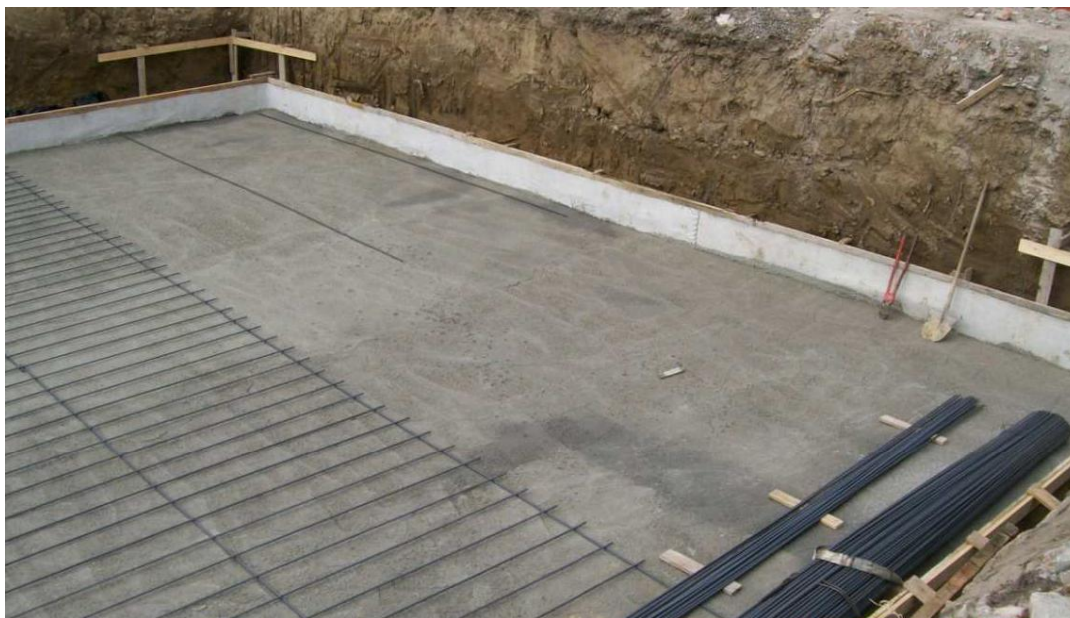
Figura 7: Cappa di protezione gettata sopra il Bentotelo
