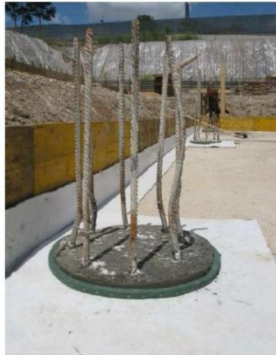
Figura 11: Impermeabilizzazione della testa dei pali con telo bentonitico.
