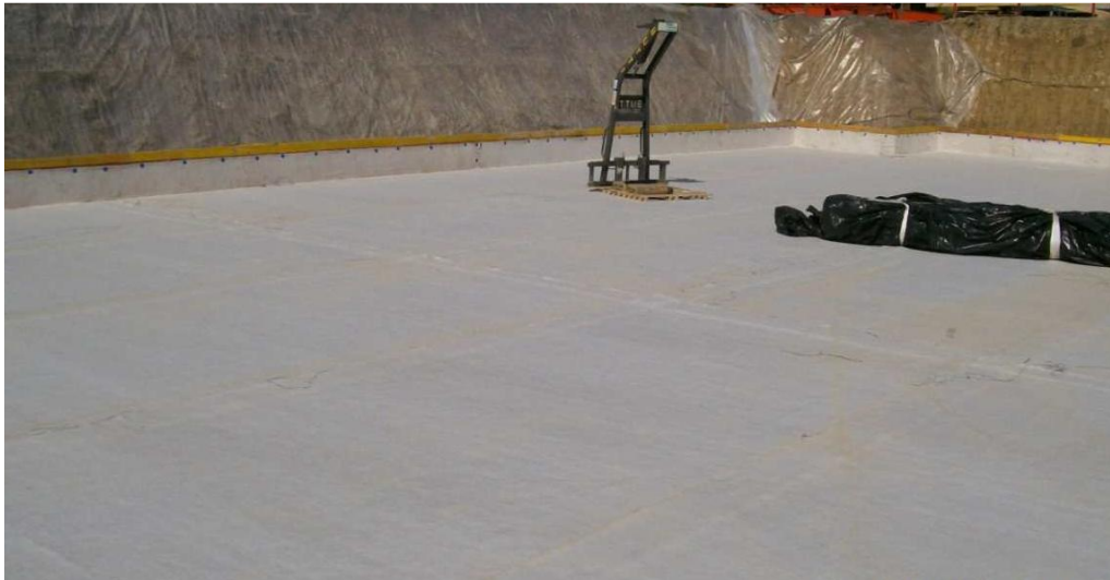
Figura 5: Stesura del Bentotelo sul magrone di regolarizzazione
