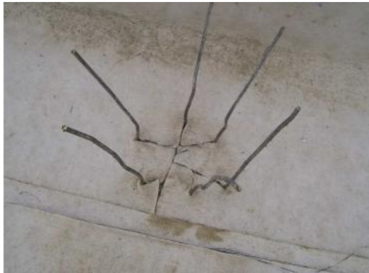
Figura 12: Impermeabilizzazione della testa dei pali con telo bentonitico.
