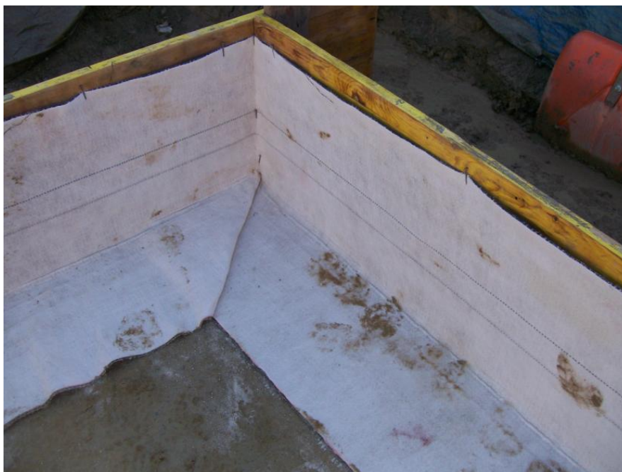
Figura 3: Stesura del Bentotelo su un angolo chiuso
