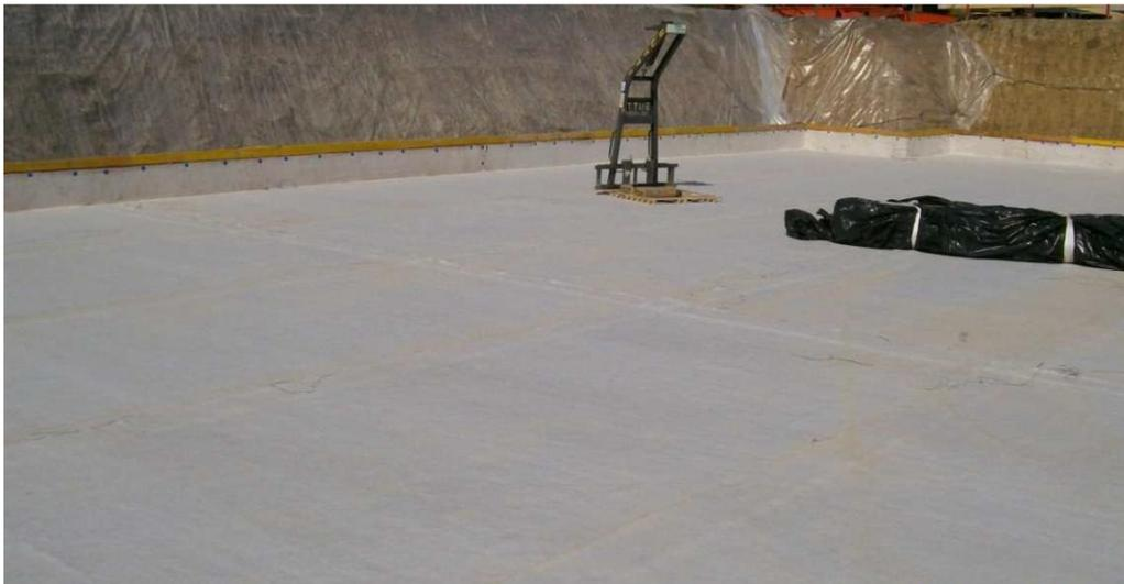
*Figura 5: Stesura del Bentotelo sul magrone di regolarizzazione*
