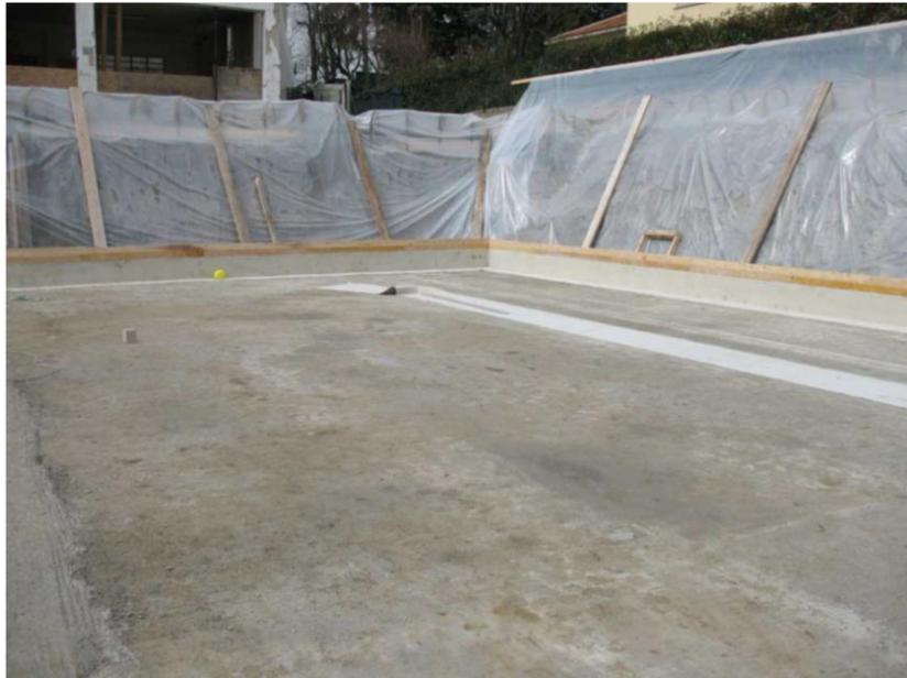
*Figura 1: Preparazione del piano di posa*
