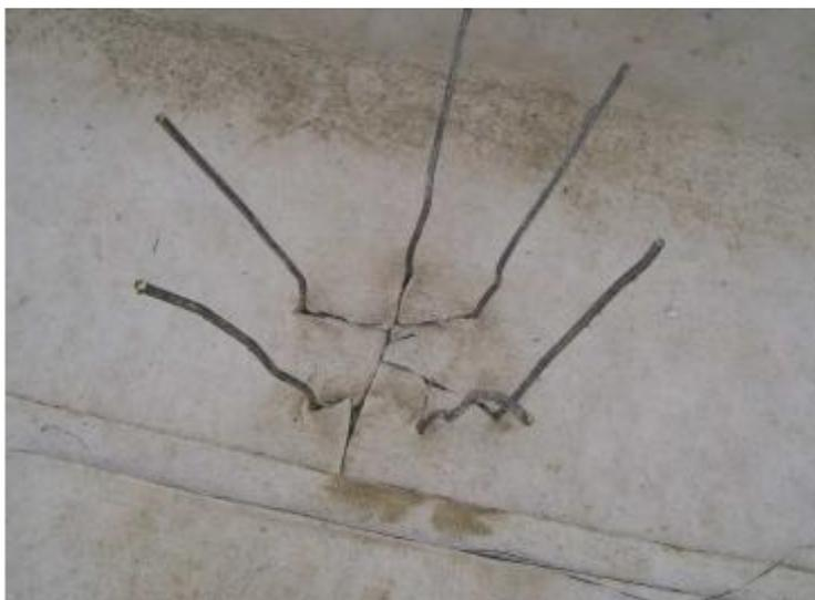
Immagine 9 – Impermeabilizzazione della testa dei pali con telo bentonitico.
