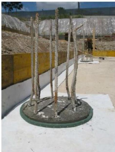
**Immagine 8** – Impermeabilizzazione della testa dei pali con telo bentonitico.
